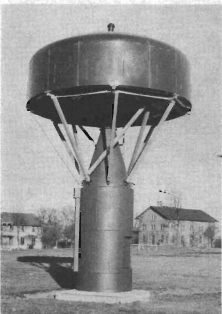
Fig 11. Det mekaniskt roterande antennsystemet för Dopplerpejlen är inneslutet i en radom av glasfiber.
