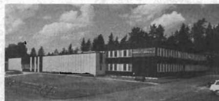
Fig 1. SGS-Fairchilds nya fabriksbyggnad i Märsta.
