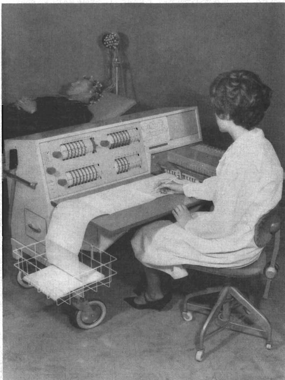
Fig 8. Elektroencefalografen »Mingograf EEG», var bland de allra första medicinska skrivare som var helt transistorbestyckade. Elektroencefalografer används för registrering av hjärnans elektriska aktivitet. »Mingograf EEG» har 16 registreringskanaler.
