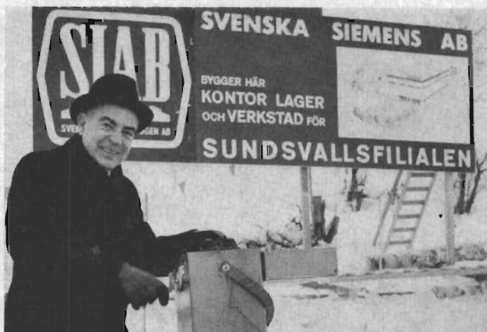
Svenska Siemens verkställande direktör, Arne F. Feichtinger, startar byggnadsarbetena för företagets nya fastighet i Sundsvall
