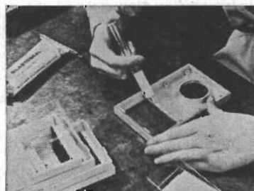
Fönstret i Evershed's megger BM6 är säkert limmat i plastkåpan med Silastoseal B, som ger en permanent lufttät fog vilken utestänger damm och fukt.
