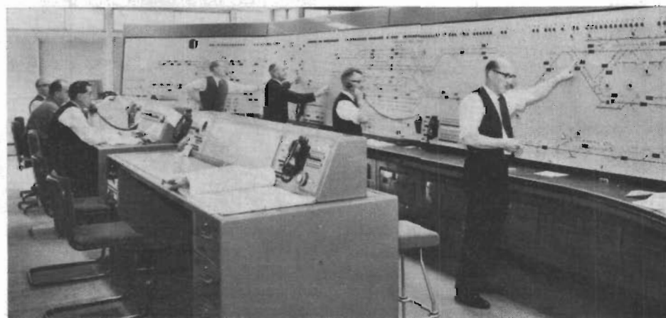
Fig 5. Moderna fjärrkontrollsystem innebär – utom de rent tekniska fördelarna – även att personalstyrkan kan reduceras, eftersom mycket stora trafikområden kan övervakas från en enda central.
