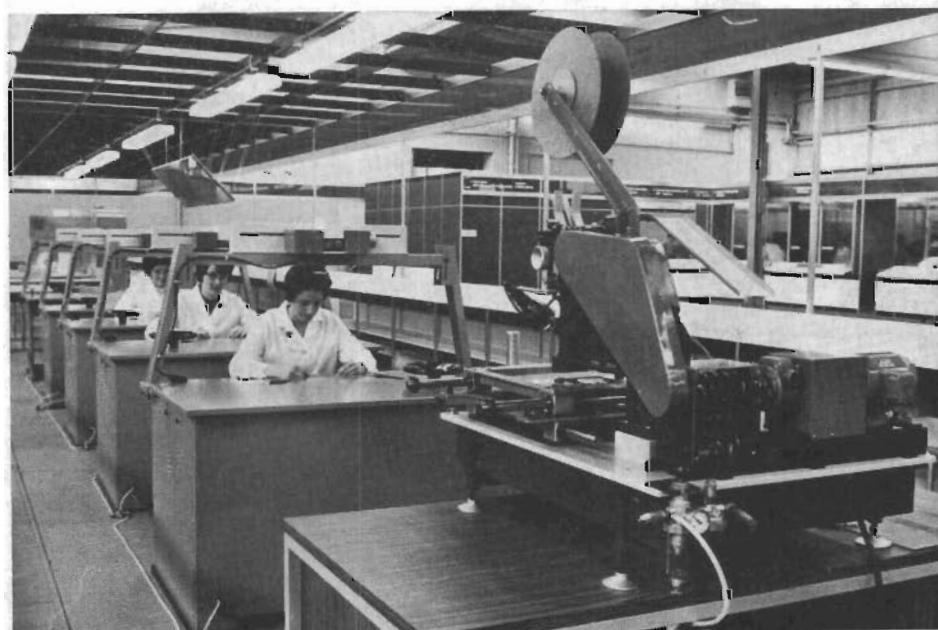
Fig 7. Montering av komponenter på foliekort.
