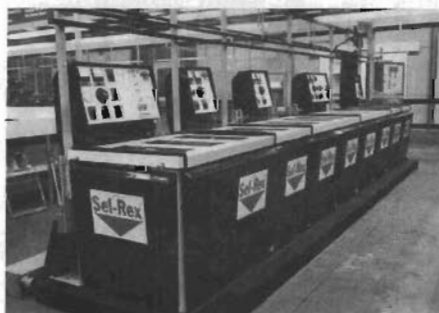
Fig 5. Anläggning för förgyllning
