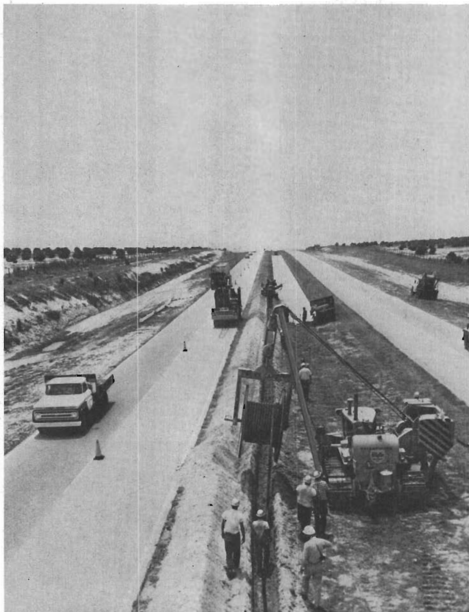
Fig 4. Koaxialkablarna förläggs i allmänhet på ca 1,2 m djup och tål då ett övertryck av 150 psi.
