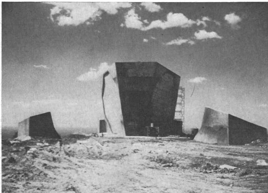
Fig 6. Antenn (ca 10 m diameter) för troposfärspridningsförbindelser. En antenn av denna typ är alltför stor för att den skall kunna skyddas helt av den omgivande terrängen.
