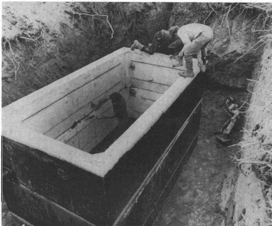
Fig 3. De mindre förstärkarstationerna för koaxialkabel-förbindelser är inbyggda i »betongbrunnar» som täcks med ett ca 0,5 m tjockt jordlager.
