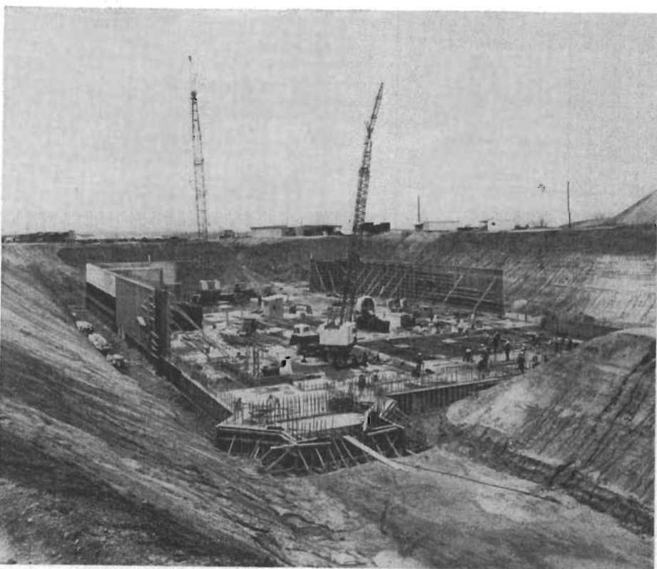
Fig 2. Den byggnad som här håller på att uppföras skall inrymma en bemannad underjordisk huvudstation för bärfrekvenssystem.
