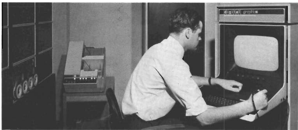
Fig 1. Med fem timmars effektivt arbete vid bildskärmen kan man klara layouten av ett typiskt dubbelsidigt mönsterkort för 25-talet DIL-kapslar, 8 kondensatorer och 8 motstånd.
