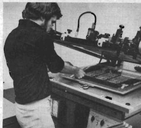
Noggrant mönstertryck – fina inställningsmöjligheter med halvautomatiskt screentryck.
