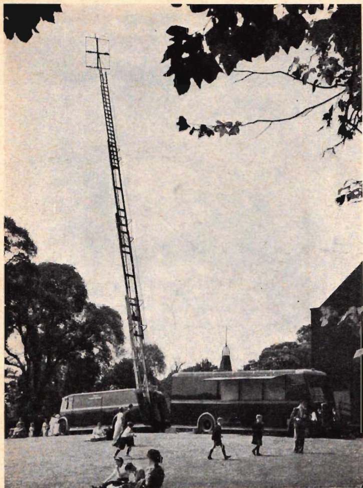
Fig. 25. B.B.C:s televisionsbilar i arbete. Sändarantennen har monterats på toppen av en brandstege, som snabbt kan skjutas i höjden. Effekten vid toppmodulation uppgår till ca 1 kW och våglängden är ca 5 meter.
