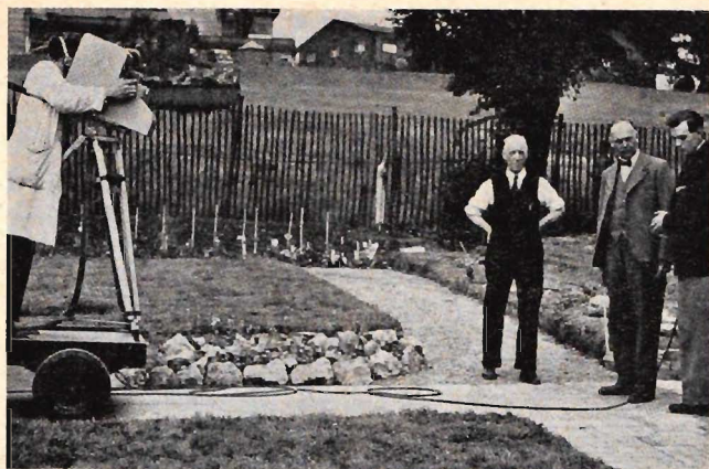
Fig. 27. Televisering från trädgårdstüppan — ett »O.B.» från London. Den på sandgöngen synliga kabeln leder till mikrofonen, som vid detta tillfälle bars av intervjuaren. Till vänster kameran, monterad på en vagn.
