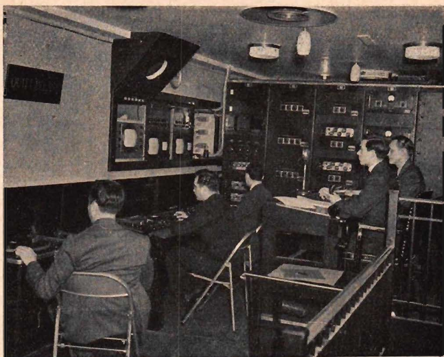
Fig. 103. Televisionssändarens hjärna — kontrollrummet. Bilden visar ett av NBC:s kontrollrum i Radio City. Till vänster på väggen en monitorpanel med bildrör och katodstrålrör för vågformskontroll. Där- under en färgad glasvägg, genom vilken scenen i studion observeras.
