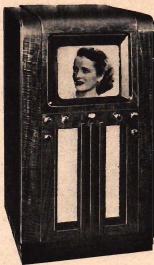
Fig. 120. Du Mont Model 183A, en modern televisionsmottagare av den populära »low console»-typen med ungefär en meters höjd. Det elektriska bildröret har liten längd och stor skärmdiameter och giver en 10×8 tums bild. Ej mindre än 21 rör utom bildröret ingå i kopplingen.
