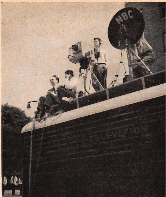
Fig. 75. En av NBC:s televisionsbussar med kamera i aktion på vagnstaket. Mikrofonen är försedd med en reflektor, som inriktad mot televiseringsobjektet förstärker den önskade signalen (med undantag för de lägsta frekvenserna).
