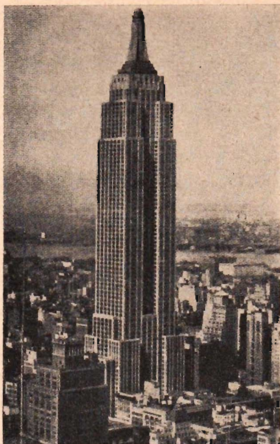
Fig. 108. Empire State Building i New York — världens högsta byggnad, 102 våningar. I toppvåningen är NBC:s televisionssändare W2x BS inrymd, som installerades redan 1932 och utgör en motsvarighet till BBC-sändaren i London.
