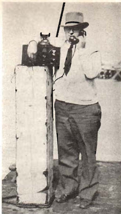
Fig. 6. Den kombinerade sändaren och mottagaren i arbete vid en av arbetsplatserna.
