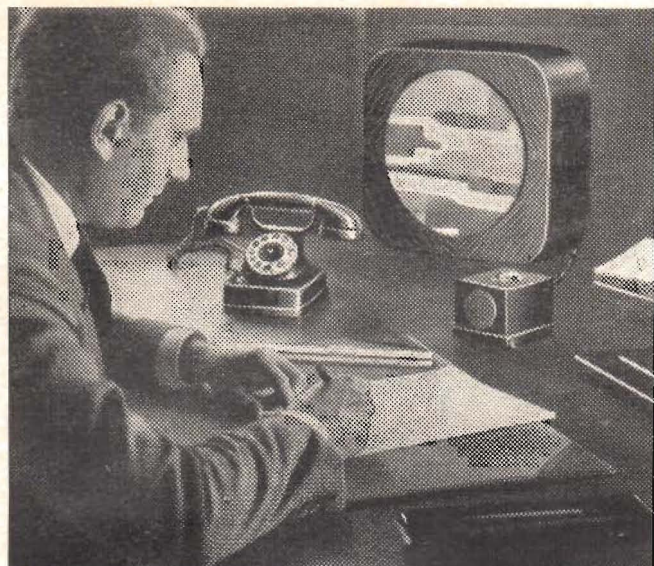
Fig. 1. Vanlig telefon kombinerad med mikrofon och högtalare. Mikrofonen ses stående på bordet strax framför högtalaren.
