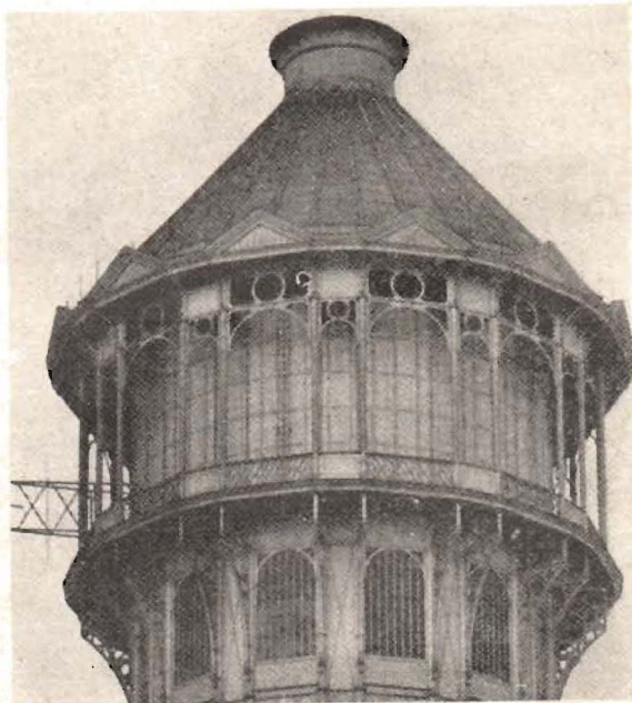
Fig. 3. Södra tornet till Kristallpalatset, varifrån Bairds försöksändningar försiggå.
