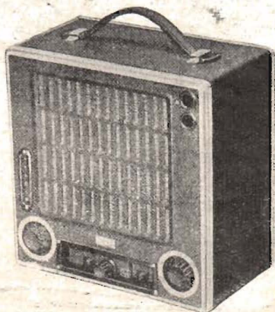
Fig. 3. Enkrets batterimottagaren »Piggi».
