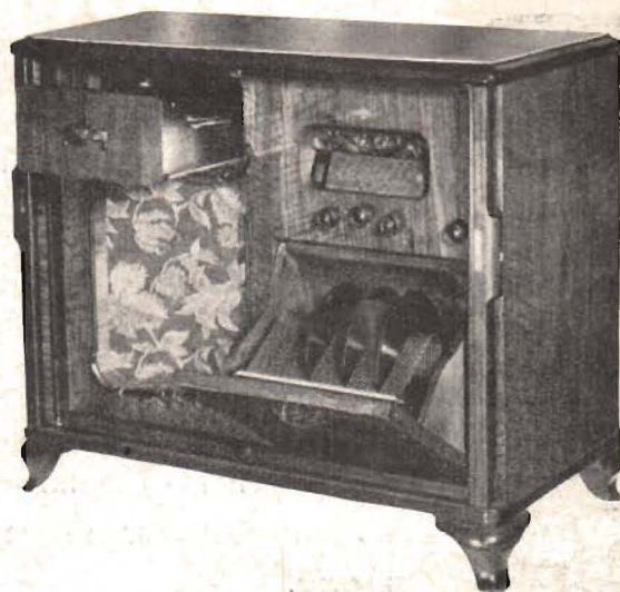
Fig. 6. Radiogrammofon i lyxutförande med 6-rörs superheterodyn och 6 W. utgångseffekt. (Stassfurt.)
