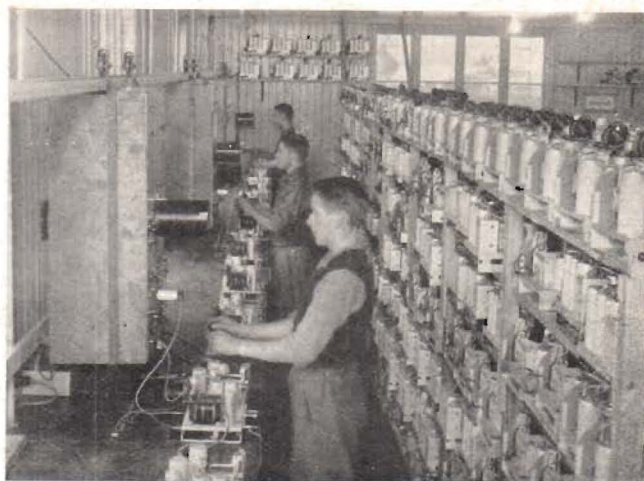
Trinning av mellanfrekvensbandfiltren medelst katodstråleosillografer i Luxor-fabriken.
