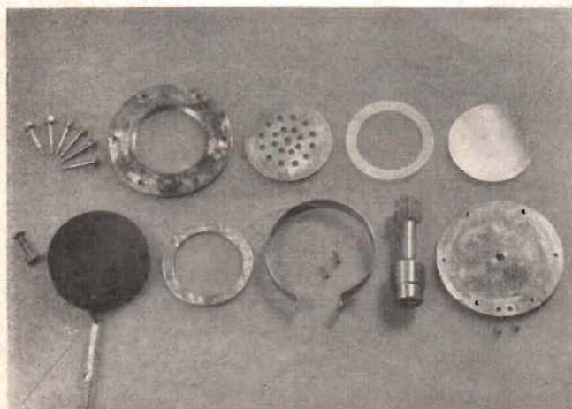
Kondensatormikrofonen sönderplockad. Samtliga detaljer återfinnas på ritningarna.
