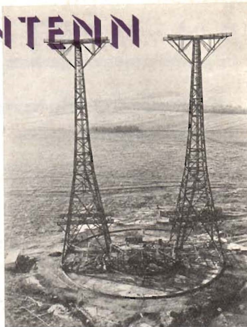
De två 60 m höga antennmasterna äro anbragta på ett vridbart funda-ment. Antennlinorna hänga rakt ned från uttriggarna högst upp.
