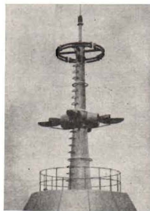
Televisionsantennerna för ljud (överst) och bild på Empire State Building i New York. Som synes användes även här horisontell polarisering.
