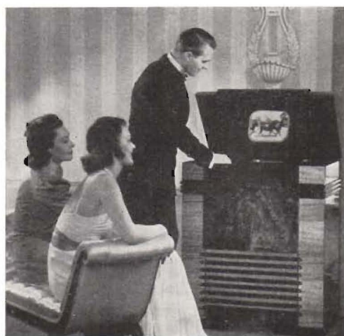
Fig. 7. RCA, modell TRK 12, en av de mest omtalade televisionsmottagarna i marknaden. Bildstorlek: 9 3/4" x 7 3/8". Totalt finnas 36 rör, av vilka en del tillhöra den inbyggda rundradiomottagaren med tryckknappar för nio stationer. För endast ett år sedan voro golvm modeller med indirekt bild praktiskt taget de enda, som funnos tillgängliga i marknaden.
