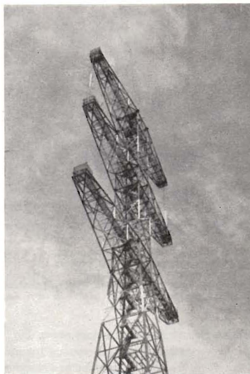
Fig. 9. Antennmasten till 40 kW stationen W2XMN i Alpine, New Jersey — en symbol för frekvensmodulationens betydelse för radion av i dag. Antennen är av »turnstile»-typ (våndkorstyp), med korsade horisontella dipoler utefter en vertikal mast, svagt synlig på bilden mellan de hitåvända ändarna av de översta två tvärsarmarna. Symmetriskt placerad finnes en liknande antenn för en mindre experimentsändare. (Foto: förf.)
