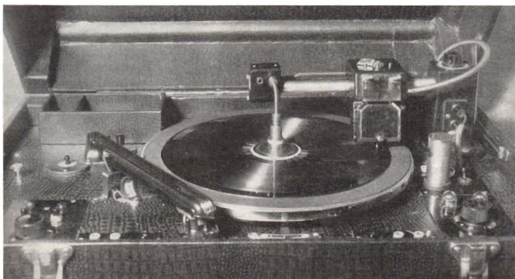
Fig. 2. Närbild av inspelningsbordet. Närmast till vänster ses signalanordningen till mikrofonerna, till höger utstyringsindikatorn med två glimlampor. Under muttern på centrumtappen ligger den tagelborste, som omtalas i texten.
