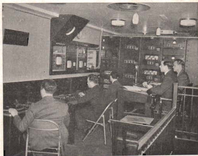
Fig. 15. Televisionssändarens hjärna — kontrollrummet. Bilden visar ett av NBC:s kontrollrum i Radio City. Till vänster på väggen en monitorpanel med bildrör och katodstrålrör för vågformskontroll. Där- under en färgad glasvägg, genom vilken scenen i studion observeras.
