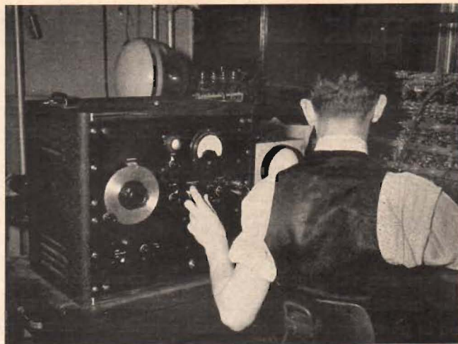
Fig. 2. Boontons svävgenerator, modell 140-A, i användning på Du Monts televisionslaboratorium i Passaic, New Jersey. Ovanför generatortorn syns ett av Du Monts bildrör med den karakteristiska, ringformade hjälpelektroden alldeles bakom skärmen.
