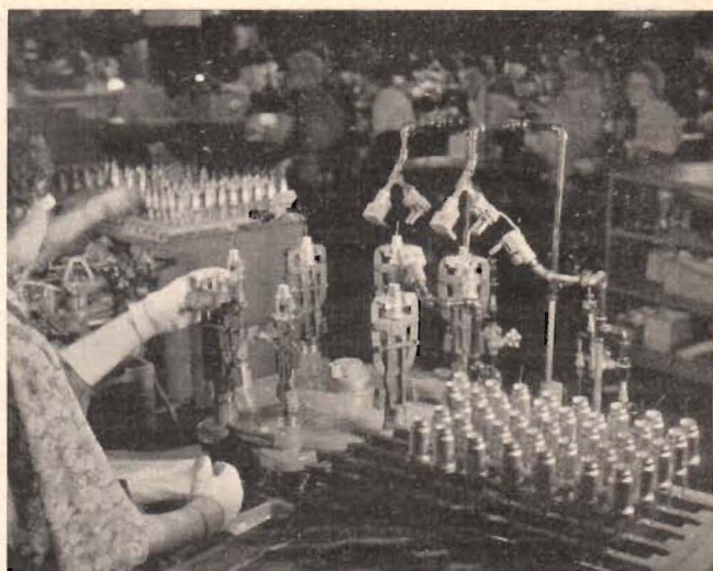
Fig. 5. En annan bild från rörtillverkningen i Harrison. I förgrunden en karusell för detaljarbete på pentodernas toppanslutning. I bakgrunden skymta några gruppmonteringslag i stora monteringshallen.
