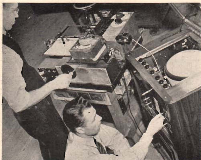
Fig. 1. Ett par RCA-ingenjörer i färd med att taga upp fidelitetskurvan för en televisionsmottagare (ljuddelen) med hjälp av den i texten omnämnda apparaten för upptagning av frekvenskurvor. Ingenjören till vänster manövrerar det handtag, som reglerar läget av ljusprojektorn, synlig omedelbart över instrumentets skala.
