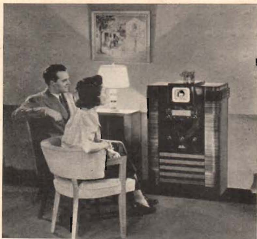
Fig. 7. RCA är den största televisionsfabrikanten i USA och hade mottagare i marknaden redan för flera år sedan. Övan ses typ TRK-5, som har 3×4 tums bildfönster, 24 rör och allvågsmottagare. De flesta televisionsmottagare i USA äro av golvmmodell.
