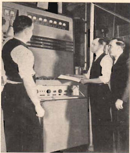
Fig. 9. RCA har i sin katalog kompletta televisionssändare, bland dem denna — visad under leveransprov — om 1 kW uteffekt. Med studiokontroller och antenn betingar stationen ett pris av 100 000 dollars.
