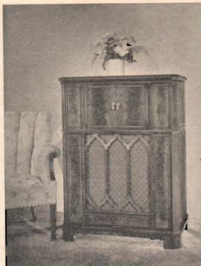
Fig. 17. Stromberg-Carlson 585-M, en av de största och mest omtalade AFM-mottagarna i marknaden. AM-enheten har mellanvåg och kortvåg samt motordriven tryckknappsavstämning. Avstämningssöga finns för AM och FM. En högtönsögtalare är monterad koncentriskt i bashögtalaren, till vars baksida en »akustisk labyrinth» är ansluten för bättre basreproduktion.
