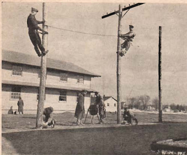
Fig. 4. En bild från Army Signal Corps School vid Fort Monmouth, New Jersey, som förfogar över ett väl utrustat radiolaboratorium. Stolparna användas för experimentuppsättningar av radio- och telefonförbindelser av det slag, som användas inom den militära kommunikationen.
