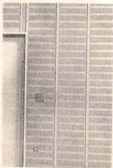
Fig. 14. Detalj av studio, visande hur glasullsabsorbenterna överklänts med skårad plywood.
