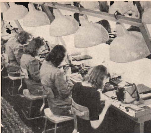
Under flödande ljus monteras och samman-svetsas elektrodsystemets olika delar.
