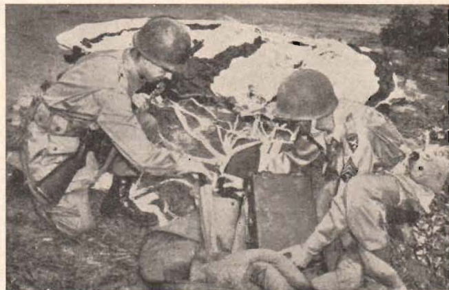
Fig. 6. Modern radiotelefon för militärt bruk med en räckvidd av 5 à 8 km packas upp av fallskärmsoldater. Apparaten går under namnet »walkie-talkie». (Fig. reproducerad ur Radio News, mars 1945.)
