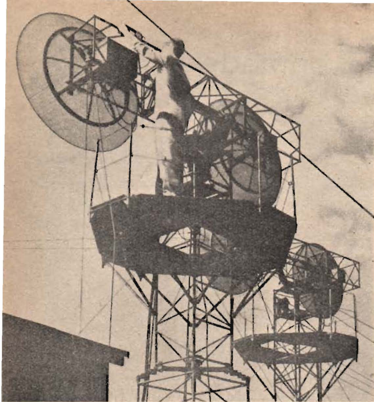
Fig. 1. Flera mikrovågssystem kunna placeras tätt intill varandra utan att de skarpt koncentrerade strålnippena inverka på varandra.
