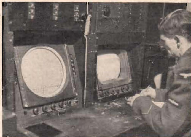
Fig. 10. Såväl A- som B-rör användas vid denna engelska typ av ekoradiostation för jaktstridsledning (eng. GCI = ground control interception). Till vänster B-röret med radiell roterande tidsaxel och rutnät för målangivning, till höger A-rör med horiscentell avståndsskala. Taggarna avvika nedåt.
