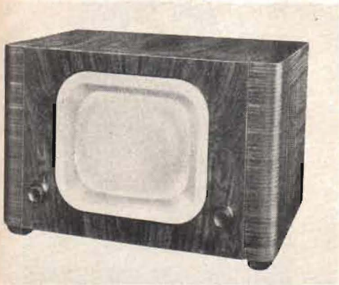
Fig. 3. Bordsmottagare för television, allströmstyp, 9" rör. Pris ca 750 kr med skatt. (PYE)
