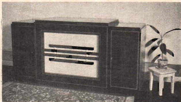
Fig. 4. Radiomöbel innehållande bl. a. en ny typ av skivbytare för 3—4 timmars skivspelning utan paus.
