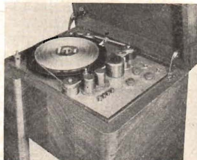
Fig. 2. Taperecorder från G. E. C. i den högre prisklassen, hastighet 7\frac{1}{2} per sekund och frekvensområdet 50—7 500 p/s.
