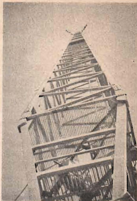
Bild av den 130 meter höga masten tagen från foten alldeles intill den steatitkula på vilken den vilar. Överst skymtar tre av de fyra fadingspröten samt isolatorerna till ett par av de fyra stagen.
