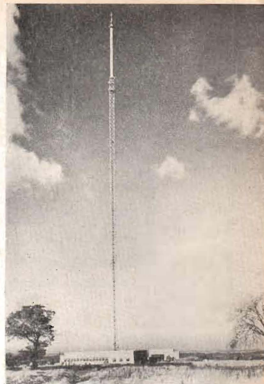
Fig. 2. Här ser man den 250 m höga masten. Den väger 140 ton och är försedd med en hiss som går upp till 200 m höjd. Längst upp ser man dipolerna för bild och ljud.
