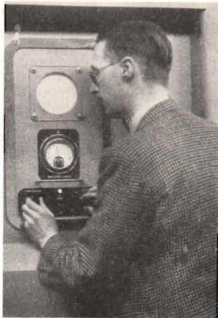
Fig. 5. Denna bild från TV-stationen i Birmingham visar ett kontrollrör, med vars hjälp man kan kontrollera den utsända bildsignalens kvalitet. Instrumentet under katodstråleröret visar signalens antitid.
