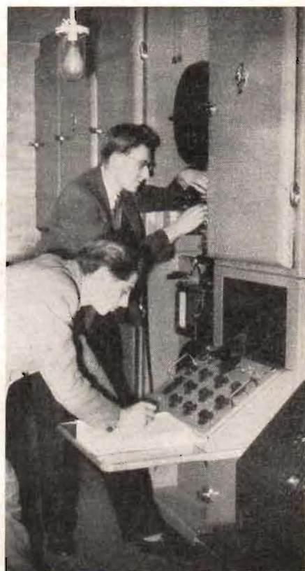
Fig. 4. Filmavsökaren med vars hjälp man kan utsända vanlig film i händelse av att det skulle uppstå fel på sändaren.
