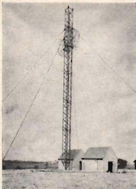
Fig. 3. Antenntorn och stationsbyggnad för en av relästationerna.
