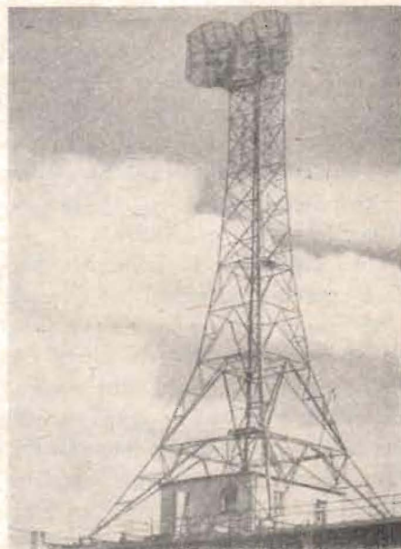
Fig. 2. Antenntornet med reflektorerna för terminalstationen i London.
