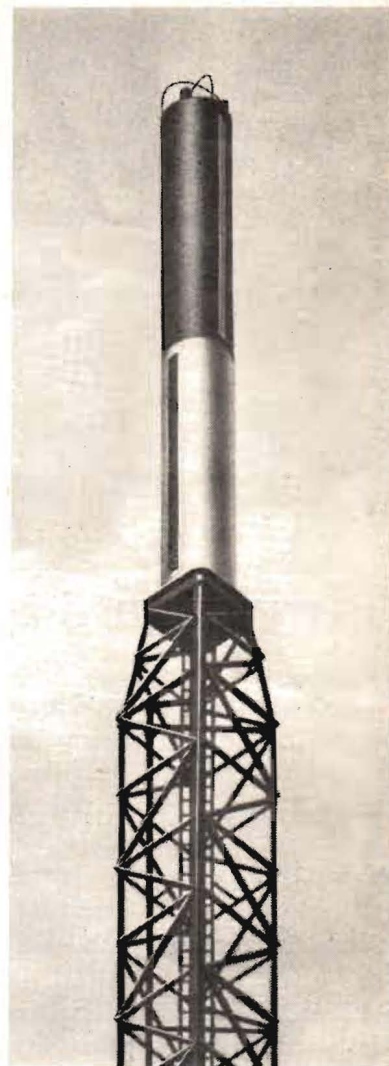
Fig. 1. UKV-antenn med två antennelement (RIAS-sändaren i Berlin).
