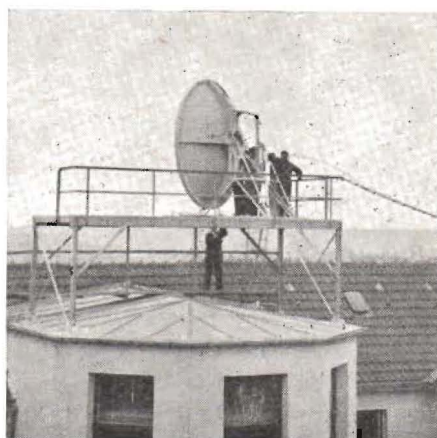
Fig. 5. Paraboloidantenn i Hannover för mikrovågssträckan Hannover—Mellendorf.
