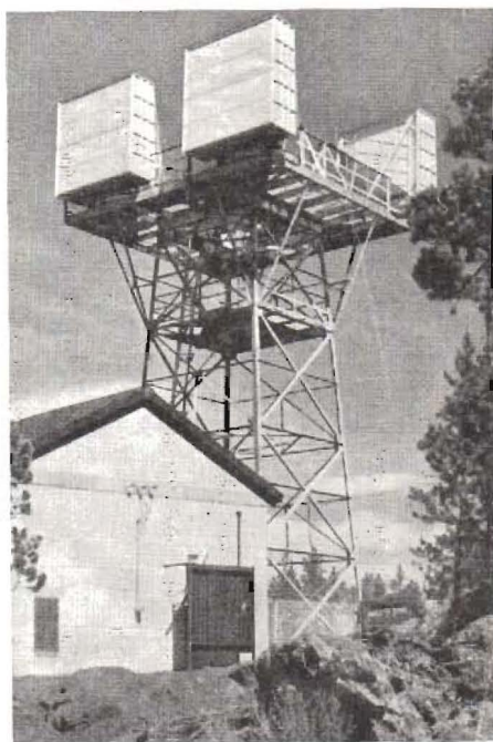
Fig. 1. Amerikanskt mikrovågstorn på Buckhorn Mountain i Colorado för relästation ingående i den transkontinentala radiolänken New York—San Francisco för TV-överföring.
