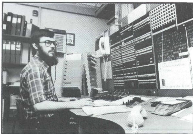
Del av växelbordet med en operatörsplats. På väggen ett av de automatiska driftlarmen.
