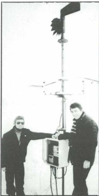
Anläggningen med repeater-kontrollenhet solcellpanel och vindgenerator. På bilden ledarna för projektet Sverre Johannesen (t v) och Kjell Olafsen-Mo.
