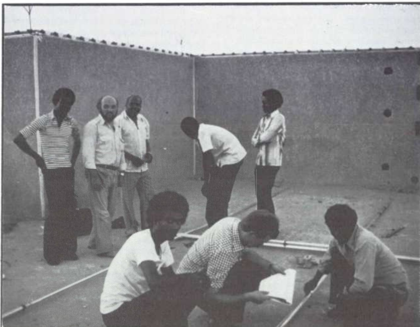
Antenn-arbete enligt sudanskt mönster. I den 60° C hettan fordrar minsta arbete enorma ansträngningar. I mitten på bilden leder Jouko, OH2BCP arbetet.
