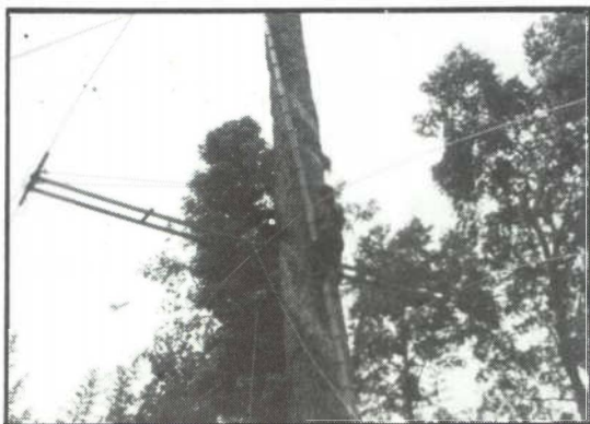
Här byts den provisoriskt tillverkade antennen till en TA-33jr. XZ9A kommer inom snar framtid att montera upp en TA-351 4 ele tribander.
