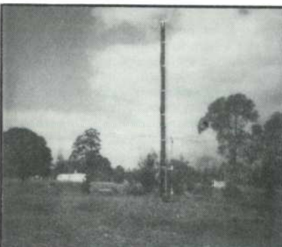
Masten är en 11 m telegrafstolpe med hissbart antennfäste.
