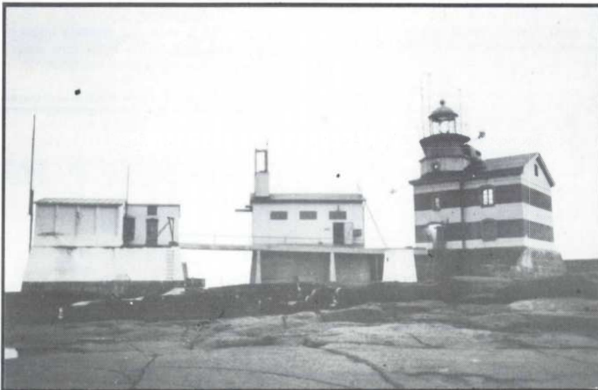
Fyren med inrymda bostäder kök etc. I mitten f.d. kraftcentral. 3 st dieslar fungerade ej p.g.a. brist av reservdel. Till vänster förrådsbod för ved, och där finns även nödradion.
