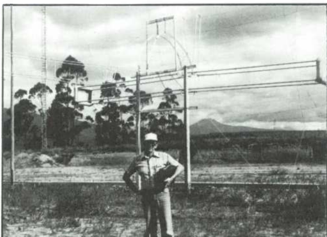
IC-701 med 100 W ut till HCJB:s folded dipole på 20 m, gav de flesta SM-kontakterna
