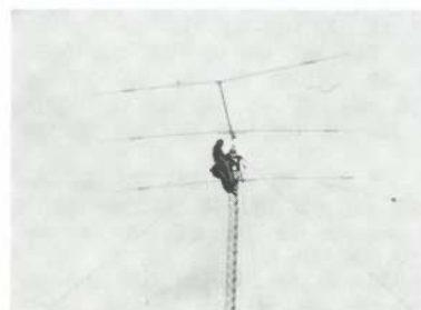
Beamen på plats. Beamen tillhör CE3ESS och är en TET HB33SP.
