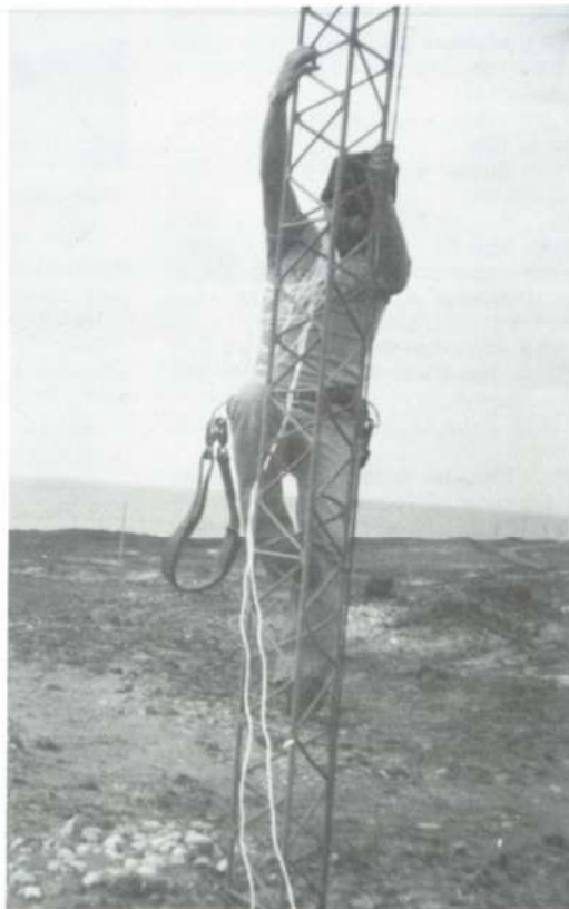
Fernando klättrar i masten där beamen var installerad, i bakgrunden syns ön San Ambrosio.
