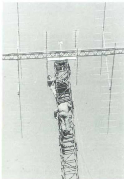
Antennmontering på Gotland: SM1ALH i masttoppen samt SM1NVT på väg upp.
