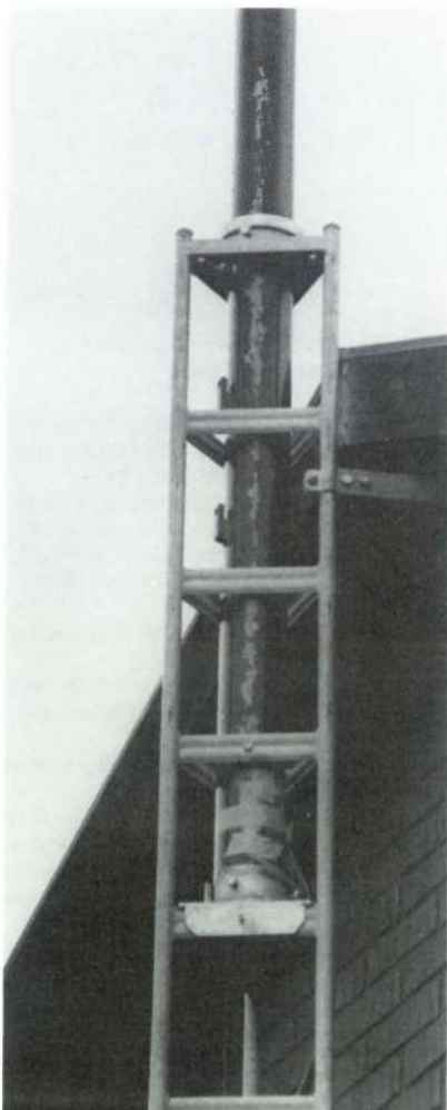
Figur 4. Läsanordning för WIBE mast.
